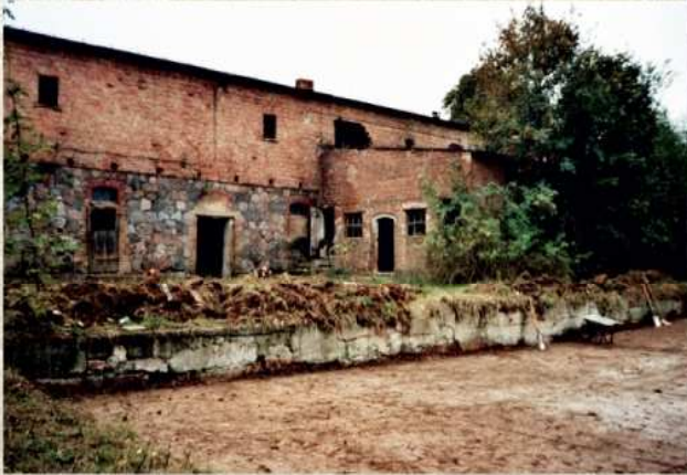
Stallgebäude mit Ablassfläche 1998 © U. Grützmaker
